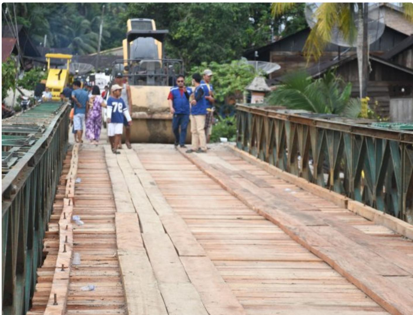
Tapanuli Tengah - Satgas Yonzipur I/DD jajaran Kodam I/Bukit Barisan berhasil menuntaskan pemasangan Jembatan Bailey di titik Jembatan Anggoli, Kecamatan Sibabangun, Kabupaten Tapanuli Tengah, pada Rabu (10/12/2025). Pemasangan jembatan sepanjang 33 meter tersebut telah mencapai 100 % sebagai bagian dari percepatan pembukaan akses pascabencana.
